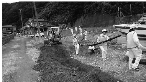
共同水道復旧作業の様子
